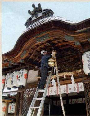
4. 本殿大鈴 修理加工
