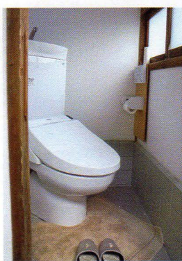
3. 下水切替工事
